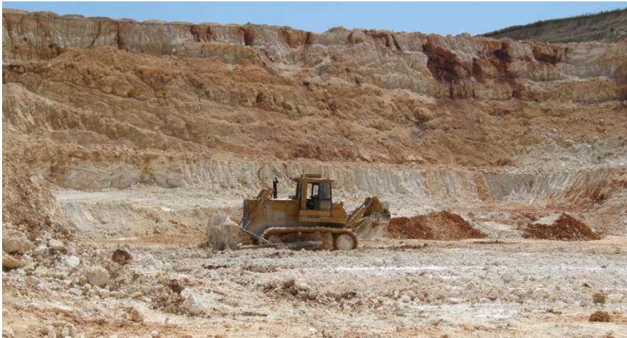
Slika 3: Metoda ripovanja i prigrivanja krečnjaka buldozerom CAT D9R
